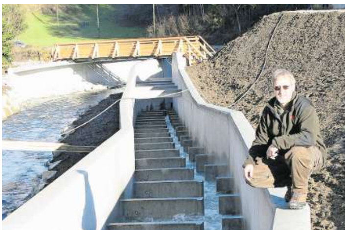
Im Uhrzeigersinn: Bei der Landi in Stans wird ein neuer Treibstofftank in den Boden versenkt. In Beckenried wird der Wellenbrecher der Fähre mit einem Kran entfernt. Beim Ausfluss des Wichelsees in Alpnach sind eine Fischtreppe und ein Überlauf mit Restwasser eingerichtet worden. Im Bild der damalige Fischereiaufseher Erwin Wallimann.
