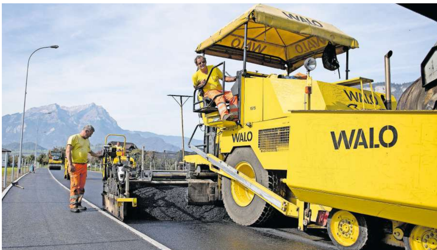
Die Belagsarbeiten an der Wilstrasse wurden gestern abgeschlossen.
