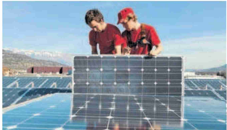
Kritik an der Subventionspraxis. Techniker montieren Fotovoltaikanlage. Foto Key
