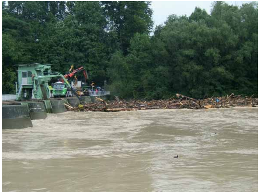
Wasserkraftwerk bei Überschwemmungssituation
